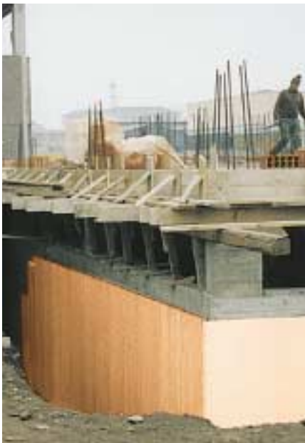
Particolare dell'isolamento del sottofinestra
